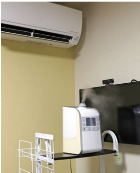
エアコン直下に噴霧装置を配置
